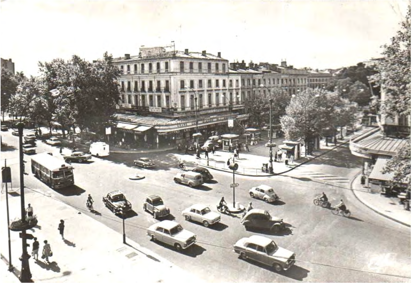
Toulouse (Haute Garonne) : Le carrefour Roosevelt et le Grand café des Américains.
